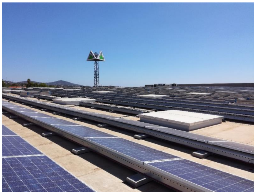
Figura 15 - Cobertura do caso de estudo captada in loco por Arq a Ana Ferreira
